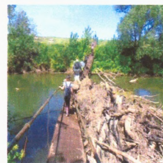
Рис. 92. Переправа по висячему мосту
